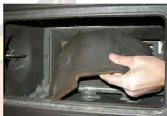
6. När andra sidan med stenar också är borttagna kan det bakre järnet tas bort och ev. bytas ut.
