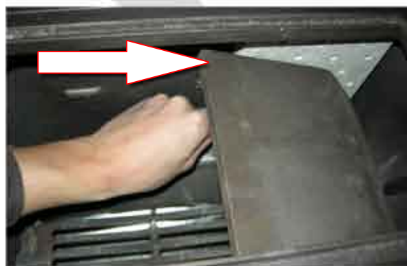
7. När de nya stenarna sedan ska sättas dit så sätts de bakre dit först. Det bakre järnet kan man hjälpa till att hålla uppe med ena handen tills första bakrestenen är på plats
