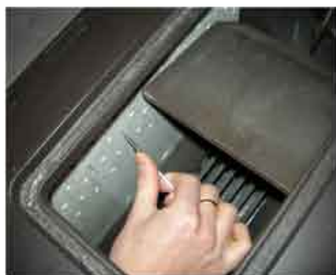
2. Öppna eldstadsluckan och för in ett smalt verktyg, t.ex. en skruvmejsel i ett av hålen i mittenstenen. (alltid mittstenen först)
