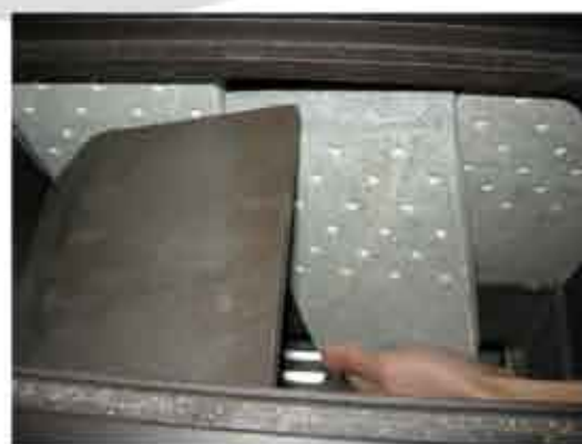
8. Mittenstenen sätts dit allra sist och. OBS Kontrollera att när alla stenar är på plats att hålbilden är uppåt och att de försänkta hålen inte är innåt eldstaden.
