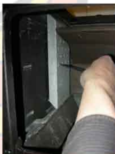
5. Dra den bakre stenen mot mitten och upprepa steg 3. (bakre stenen håller även det bakre järnet på plats)
